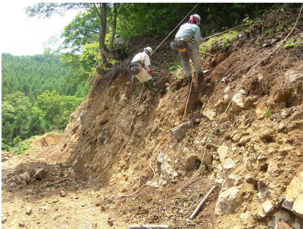
④ 法面整形（人力）
