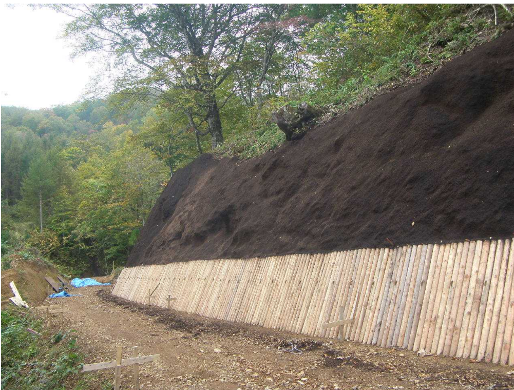
⑮ 完成後（丸太伏工）
