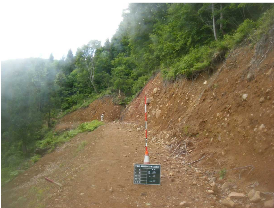
① 施工前の状況
