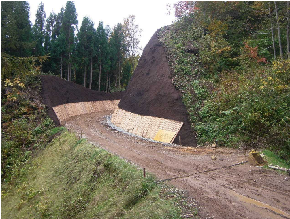
⑬ 完成後（丸太伏工）
