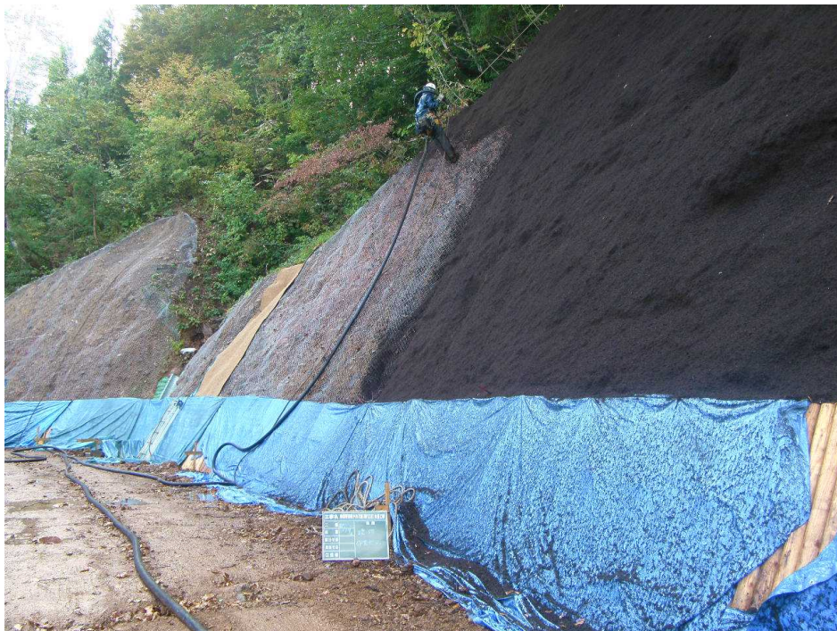
⑫ 厚層基材吹付工施工状況
