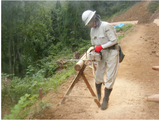
⑧ 曲線部部材の加工状況
