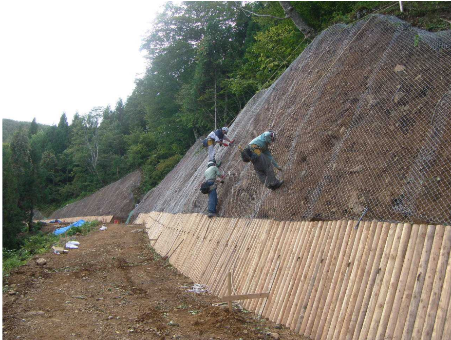
⑪ 丸太伏工上部法面の金網張工状況
