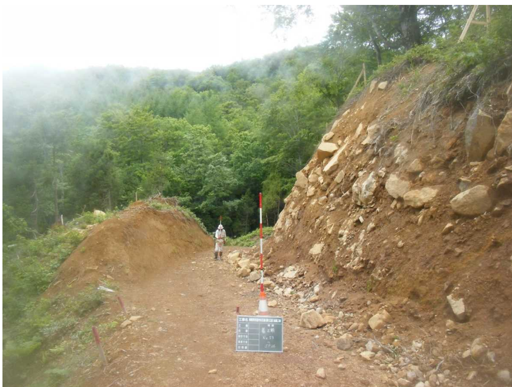
② 施工前の状況
