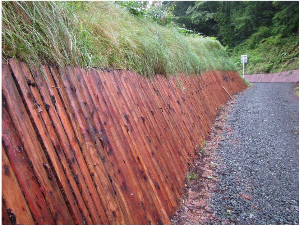
⑪ 施工後の効果（曲線部の視距確保や防草状況）
