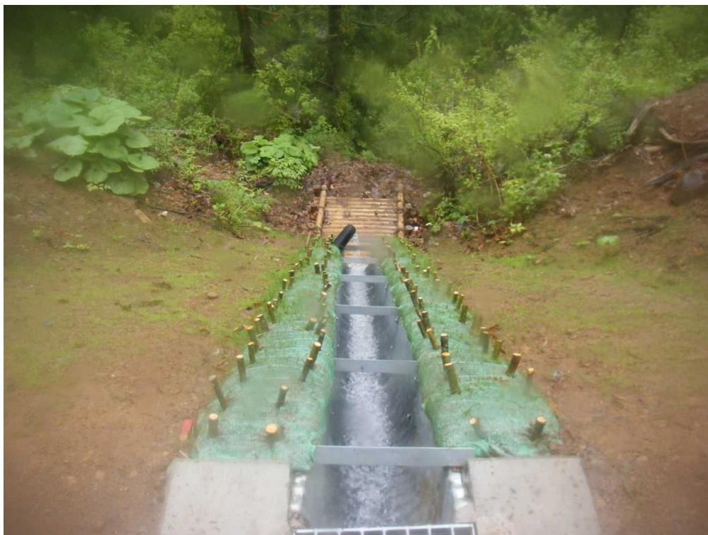
⑪ 吐口保護工の設置状況
