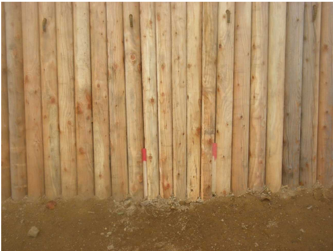
⑩ カーブで隙間防止部材の使用状況（杭表示間の部材は下部が細い）
