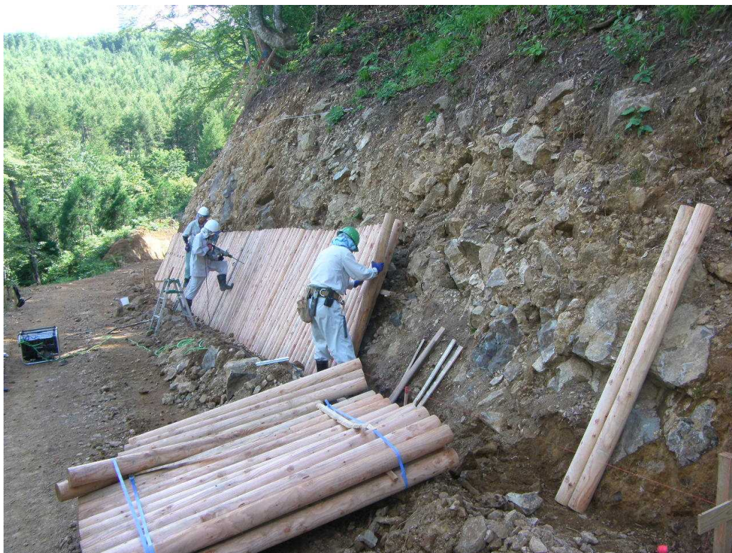
⑤ 丸太建て込み状況
