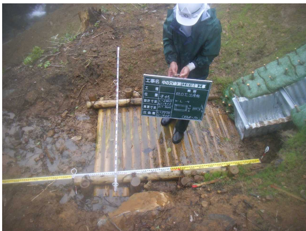
⑫ 同 上（排水施設の洗掘の防止状況）
