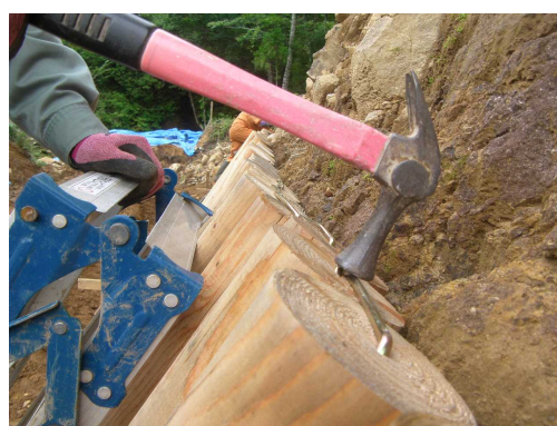
⑦ 天端カスガイ止め状況
