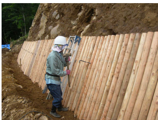
⑥ アンカーボルト打込み状況
