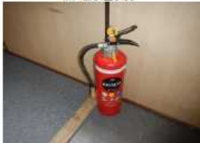
消火器設置状況
