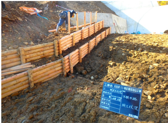
木製流路工（施工状況）
