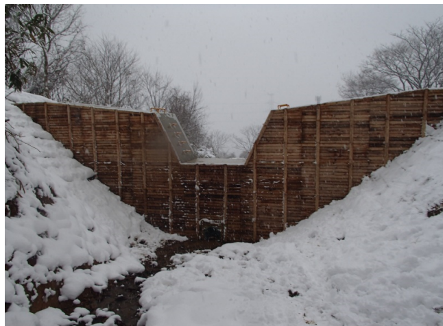
谷止工（完成状況）水表
