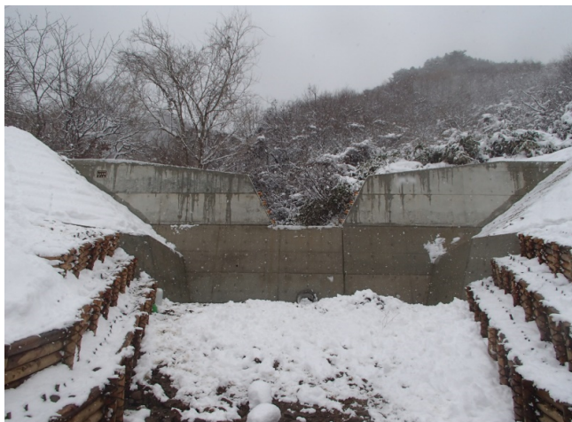
谷止工（完成状況）水裏
