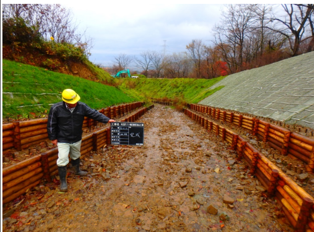
木製流路工（完成状況）
