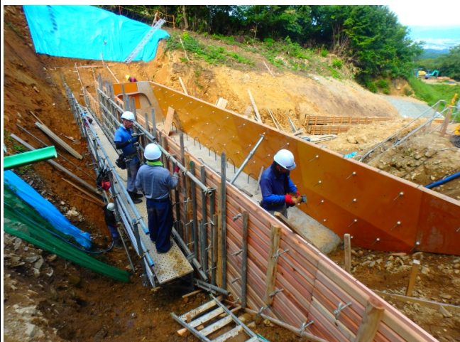
木製残存型枠（施工状況）
